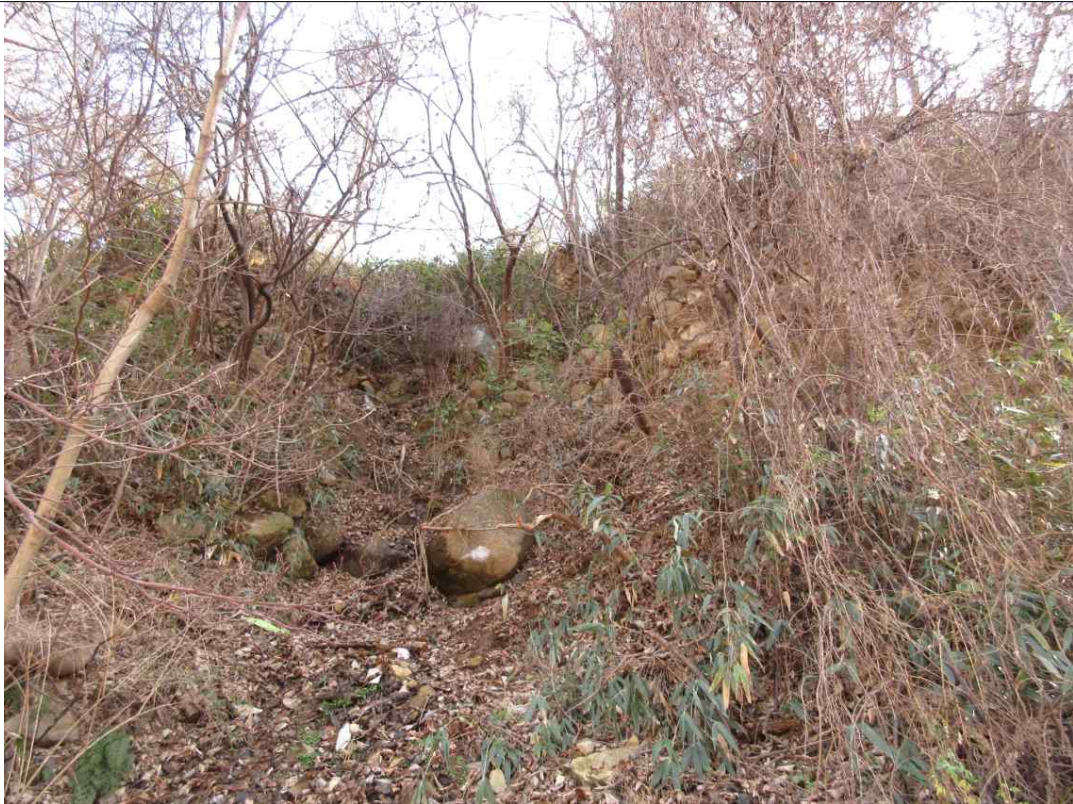
현장사진: 붕괴위험지역 전경
